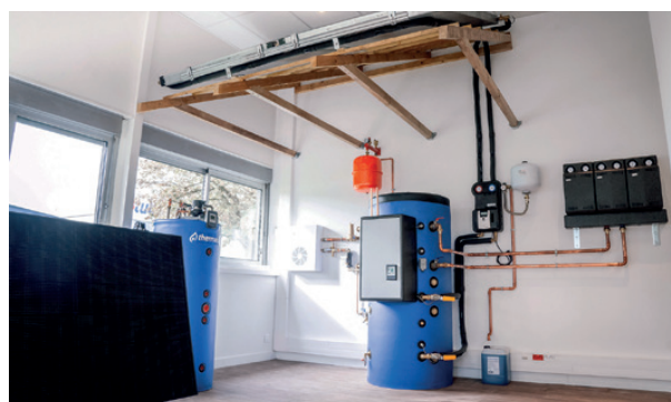
Installation d'un ballon solaire chez Thermador
