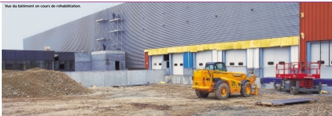
Vue du bâtiment en cours de réhabilitation.
