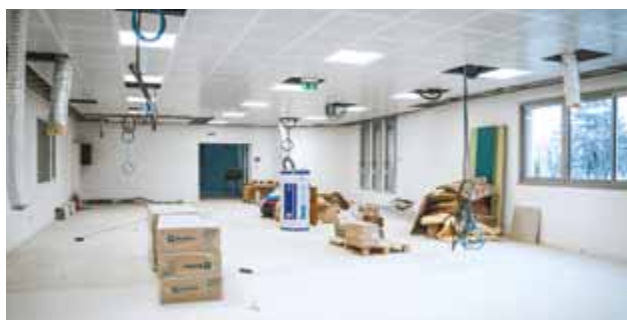
Thermador Groupe radiant ceiling.
